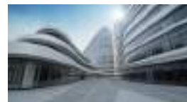
Niższe budynki wielkopowierzchniowe
